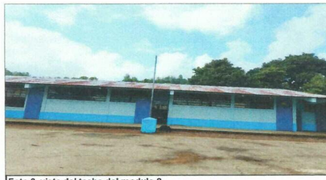
Foto 6. vista del techo del modulo 2
